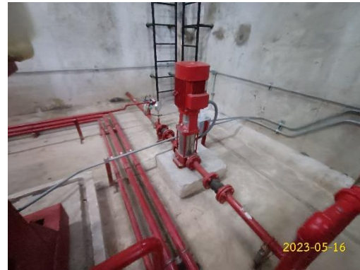
เครื่องสูบน้ำแบบเครื่องยนต์/เครื่องสูบน้ำดับเพลิงช่วย
