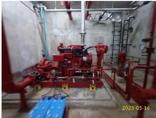
เครื่องสูบน้ำแบบเครื่องยนต์/เครื่องสูบน้ำดับเพลิงช่วย
